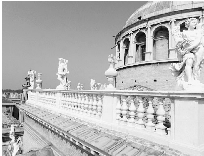
La balaustra della Basilica della Steccata
