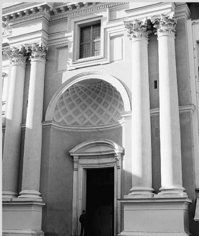
Il restauro La facciata di San Pietro dopo il recupero
